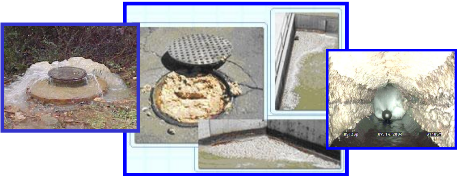
Fotos: Los efectos de la acumulación de "FOG" en el sistema de alcantarillado sanitario.
